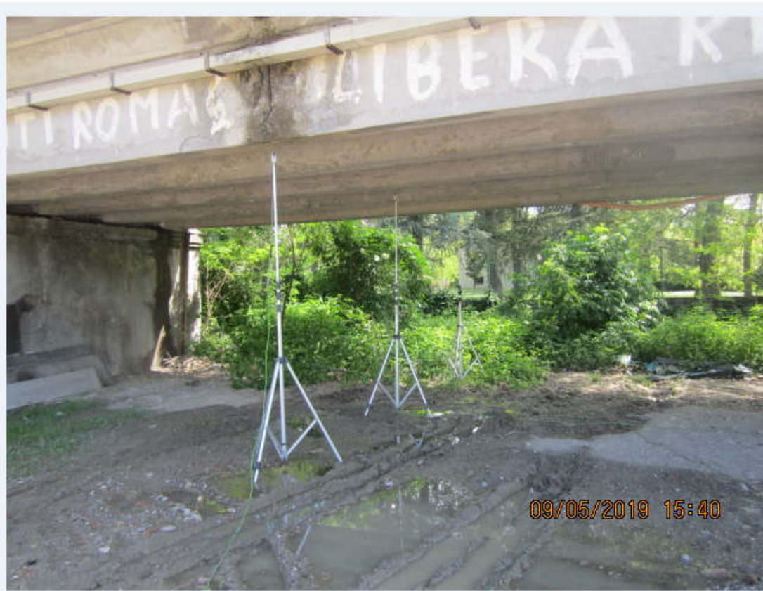
Trasduttori di spostamento nella 1.a campata lato Riolo T
