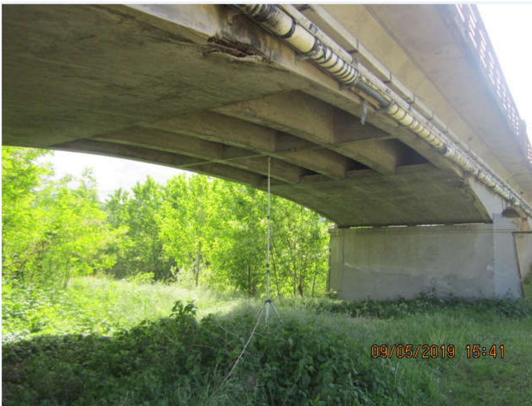
Trasduttori di spostamento nella campata 2, lato Riolo T
