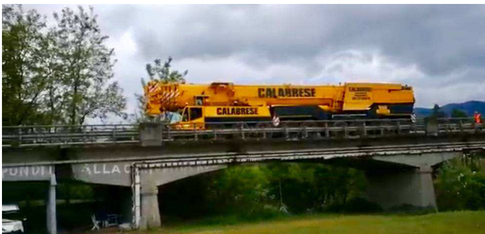
Fotografia del passaggio dell'autogrù in direzione Riolo Terme, sulla campata compresa tra Pila 1 e Pila 2.
