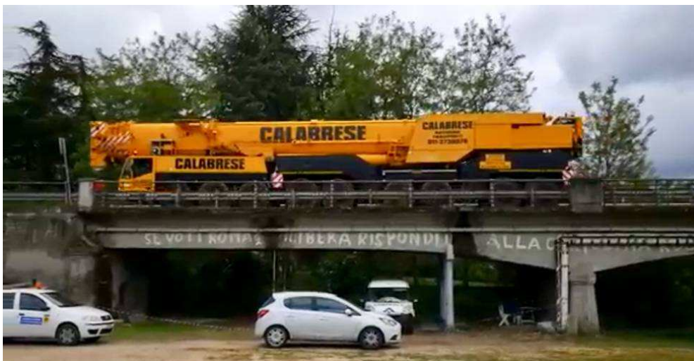
Fotografia del passaggio dell'autogrù in direzione Riolo Terme, sulla campata compresa tra Spalla Riolo Terme e Pila 1.
